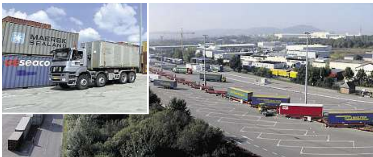
Ein Blick über das Gelände von CFL Multimodal, wie es heute aussieht
